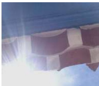
DETALHE DO BEIRAL EXISTENTE, CORTE NAS PRIMEIRAS TELHAS DO TIPO CAPA COLONIAL.
