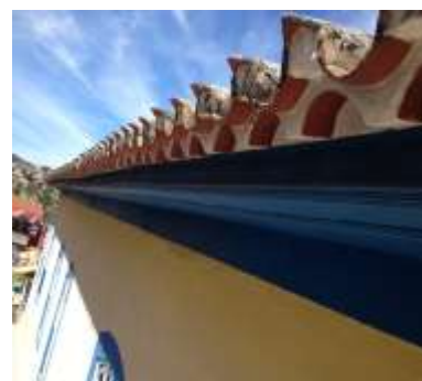
DETALHE DO BEIRAL EXISTENTE, CORTE NAS PRIMEIRAS TELHAS DO TIPO CAPA COLONIAL.
