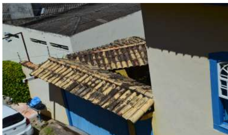
DETALHE PARA O TELHADO EXISTENTE EM CAPA E CANAL COLONIAL (BRANCO MESCLADO) DO ESTACIONAMENTO.
